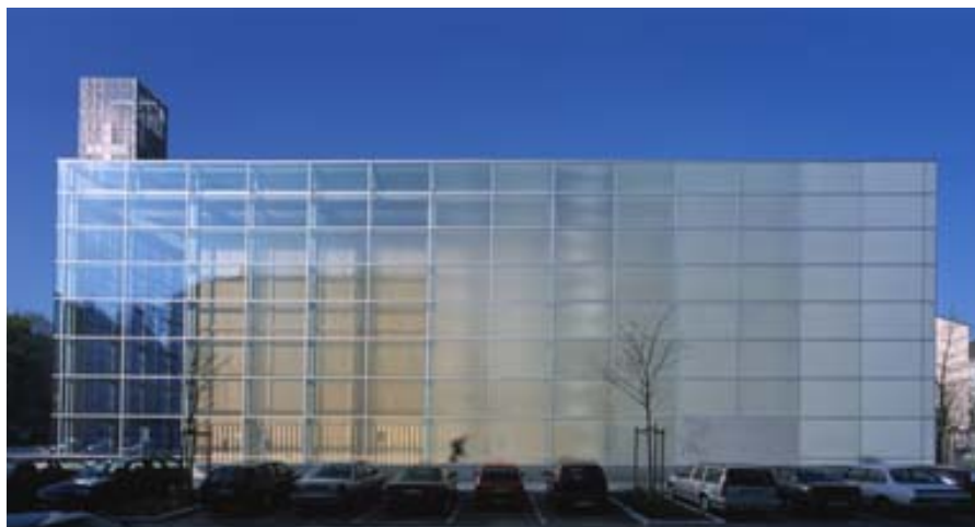
Bild 1: Tragende Glasfassade der Herz-Jesu Kirche
